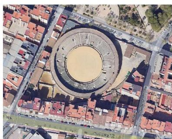
Estado actual del ámbito de la Plaza de Toros y su entorno
